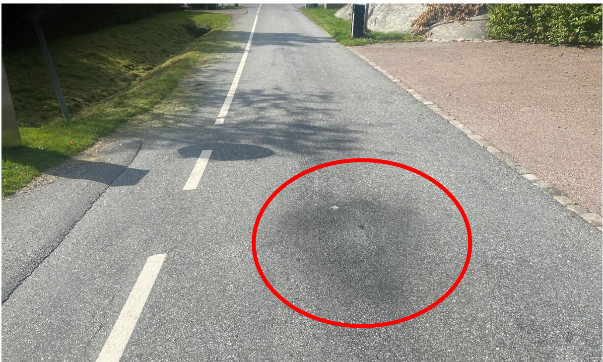
Lagning av potthål. Adress: Andalen 91.
