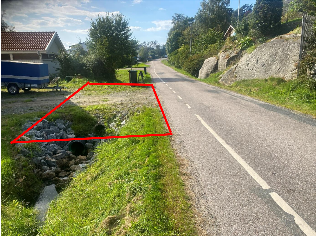
Färdigställande av dagvattenarbete. Adress: Andalen 68.
